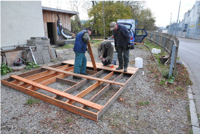
Bau eines neuen Brutfloßes für Flusseeeschwalben
