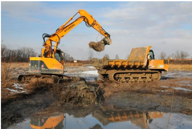
Abbildung 1: Einsatz von Bagger und Kettendumper bei Ludwigsfeld
