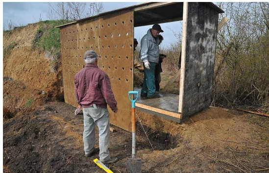
Abbildung 4: Bau der Uferschwalbenwand am Plessenteich
